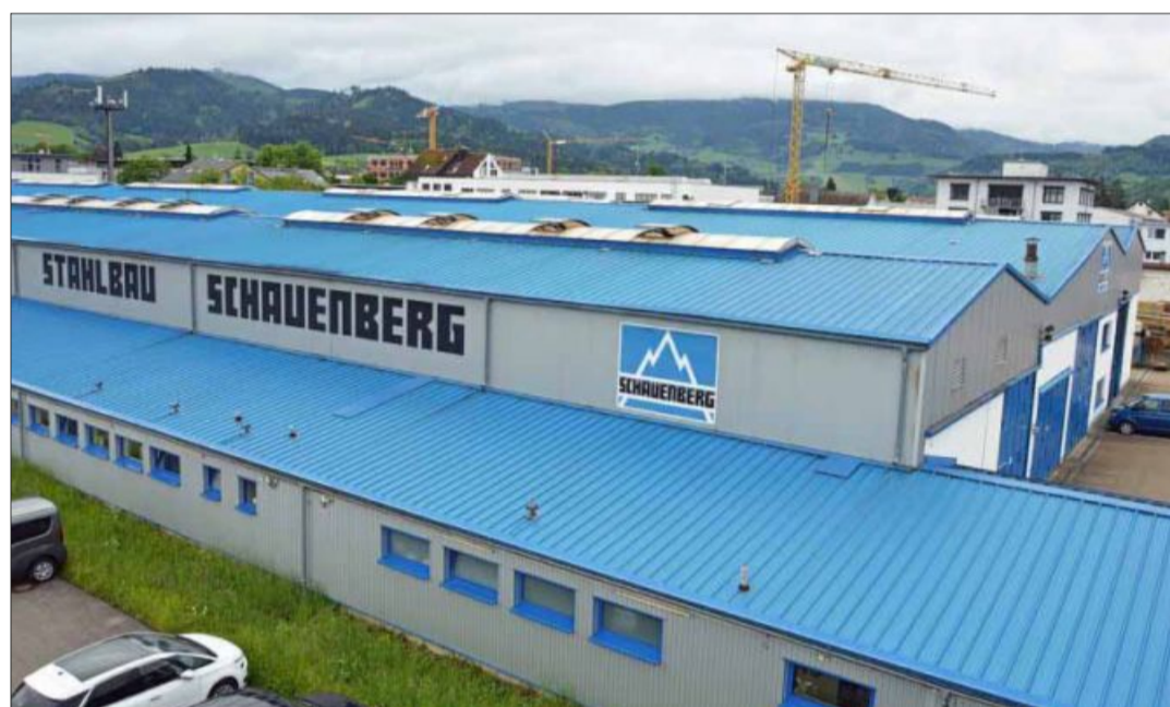
Auf diesen rund 5.000 Quadratmeter großen Dachflächen der Kirchzartener Schauenberg-Werkshallen entsteht bis Ende des Jahres die größte Photovoltaikanlage des Dreisamtals.
